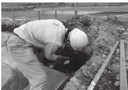
▲保護措置の一つ「工事立会」現場(参考)
