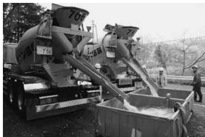
▲生コン車からの補水
