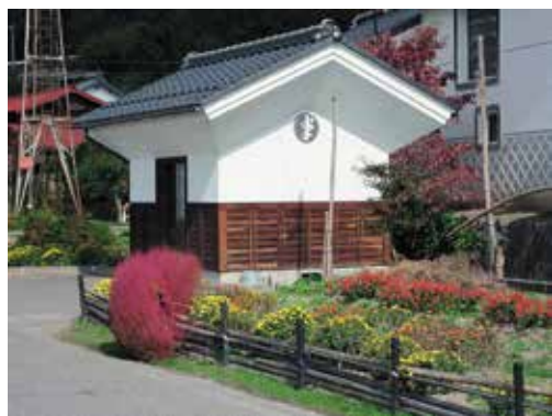
県道上生坂・信濃松川停車場線沿いの 半在家集落センター向かいに建っています
