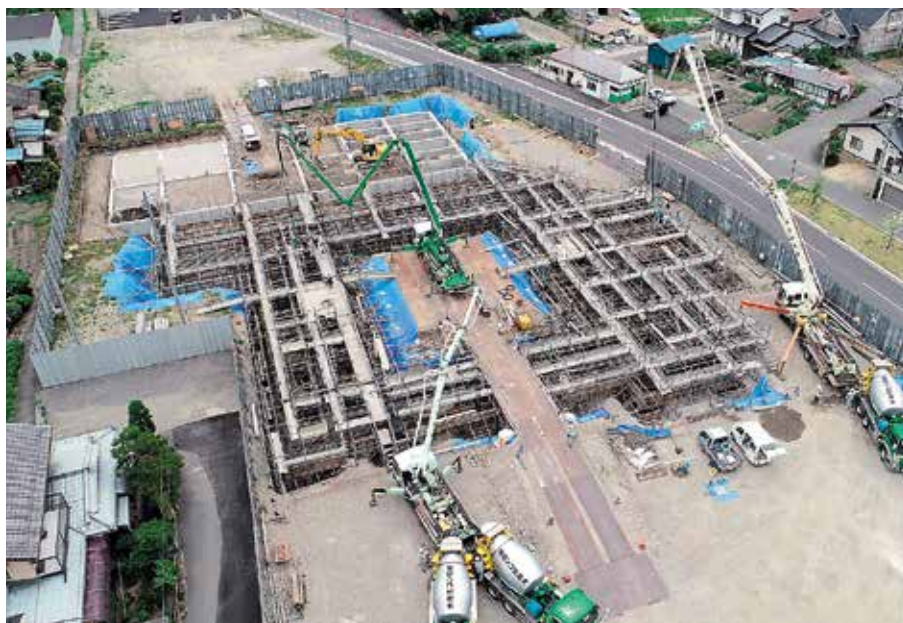
アップルランド池田店跡地周辺で建設が進む地域交流センター （上空から撮影）
