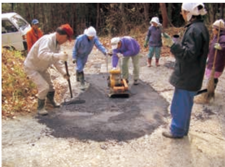
元気なまちづくり補助金での道路舗装工事
