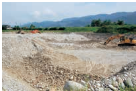
水田を掘ると高瀬川の川原と同じ砂利が現れる （松川村の砂利採取場）
