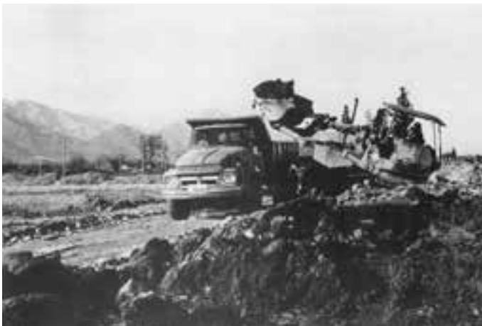
土地基盤整備工事
