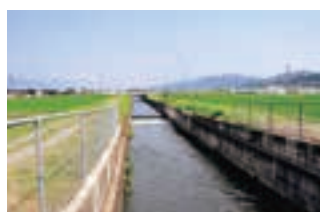
整備された内川排水路
