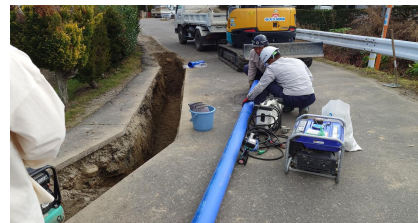
水道管の布設替工事
