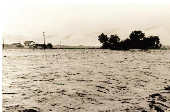
ダムがない頃の大雨時の高瀬川 (昭和44年)
