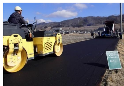
アスファルト舗装
