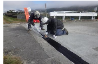
道路橋の修繕
