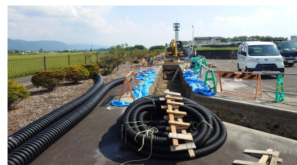
汚水処理施設の更新工事
