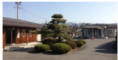
池田町松川村葬祭センター（豊町）
