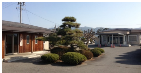
池田町松川村葬祭センター（豊町）
