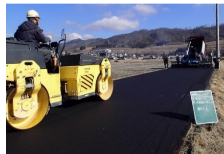
アスファルト舗装
