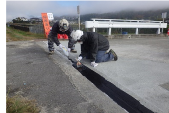
道路橋の修繕
