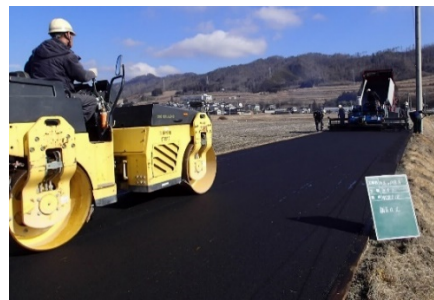
アスファルト舗装
