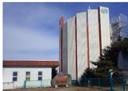
低区配水池（五丁目）
