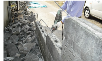
ブロック塀の除却
