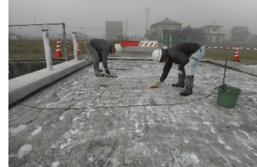
道路橋の修繕
