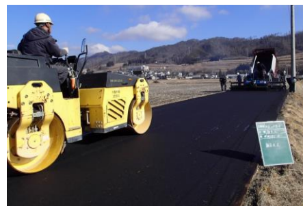
アスファルト舗装
