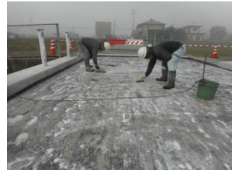
道路橋の修繕
