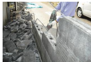
ブロック塀の除却
