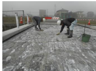
道路橋の修繕
