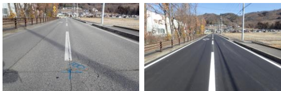
町道滝沢バス停連絡線 舗装修繕工事(R2年度実施)
