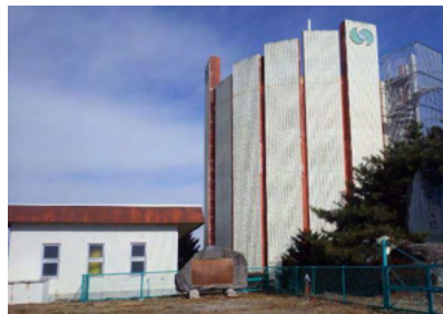
低区配水池（五丁目）
