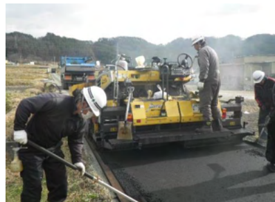
アスファルト舗装
