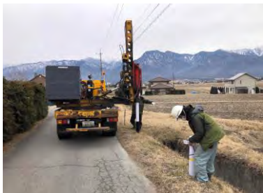
ガードレールの設置
