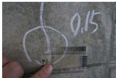
道路橋の点検
