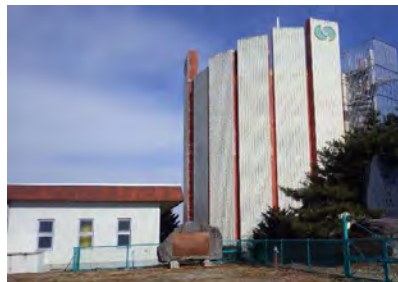
低区配水池（五丁目）
