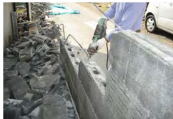
ブロック塀の除却
