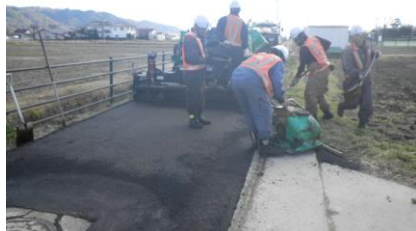
アスファルト舗装
