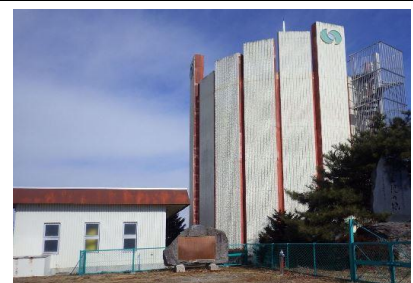
低区配水池（五丁目）
