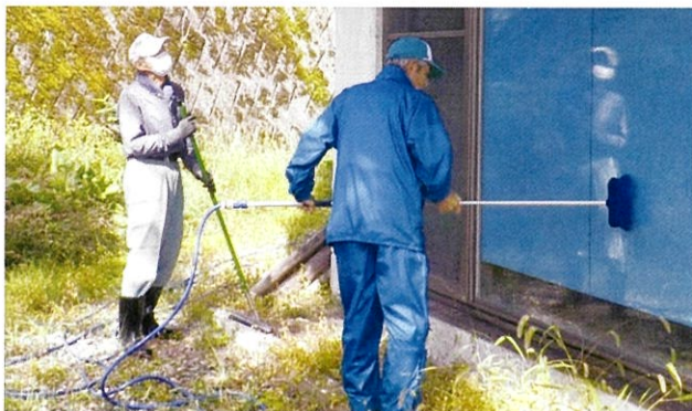
小谷地区 10月2日 8名参加 小谷村福祉センターせせらぎ 外壁・窓清掃など
