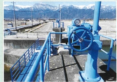
県単補助事業箇所 五丁目放水路水門改修
