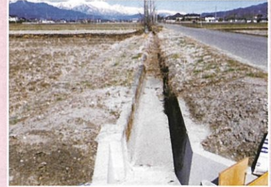
農業水路長等寿命化・防災減災事業 水路改修内鎌地区（2ヶ年事業）
