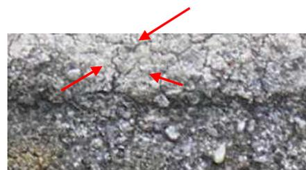
●シーリング材表面のひび割れ
