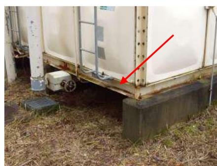
●受水槽架台の腐食
