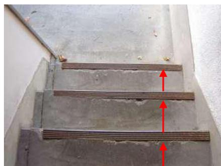
●ノンスリップの腐食（さび）、踏面コンクリートの欠損
