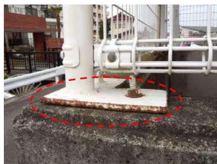
●ゴミ置場支柱柱脚の錆
