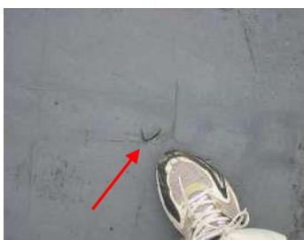
●防水層の破断、損傷\*2
