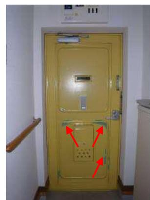
●住戸玄関ドアの塗装の剥離
