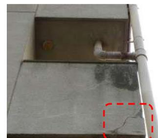
●バルコニー腰壁のひび割れ、欠損
