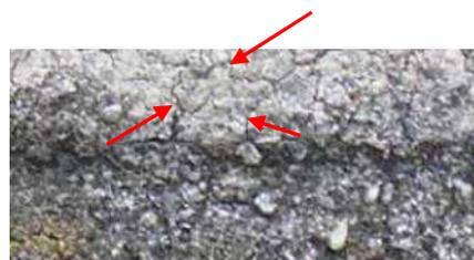
●シーリング材表面のひび割れ
