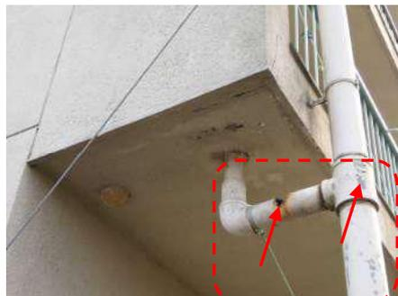
●雨樋の劣化、ひび割れ、塗装の剥がれ
