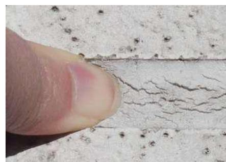
●指圧による亀裂の深さの確認
