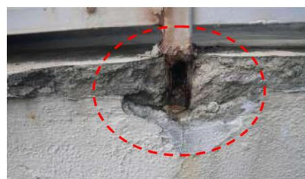
●支柱固定部分の腐食（さび）から発生した鉄筋コンクリートの欠損
