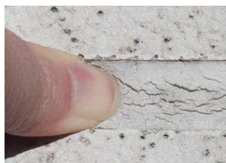
●指圧による亀裂の深さの確認
