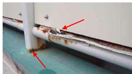
●鋼製手すりの腐食（さび）
