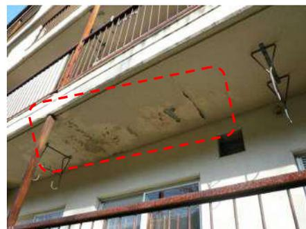
●バルコニー片持ちスラブ下面の仕上げ材のはがれ、鉄筋の露出
