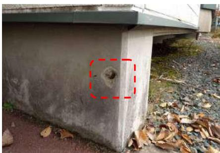
●基礎の鉄筋の露出
