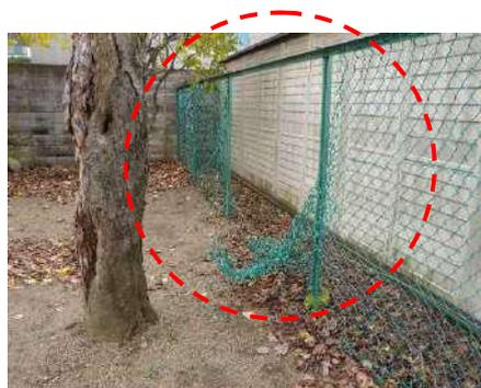
●金属フェンスの変形、破損
