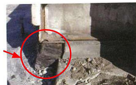
●立上り周辺部の欠損による防水層の露出\*1
