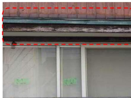
●金属屋根葺き材の腐食（さび）
