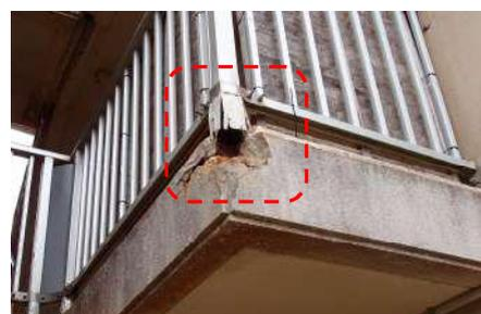
●手すり支柱固定部分の剥落
