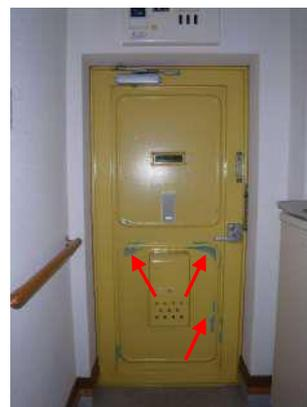
●住戸玄関ドアの塗装の剥離
