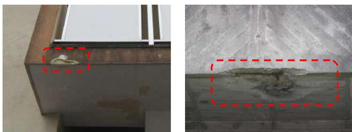
●バルコニー先端部の欠損
