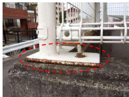
●ゴミ置場支柱柱脚の錆
