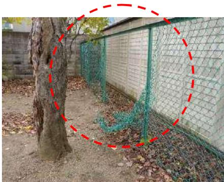
●金属フェンスの変形、破損
