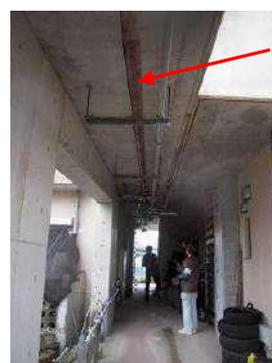
●横引き管の腐食（さび）
