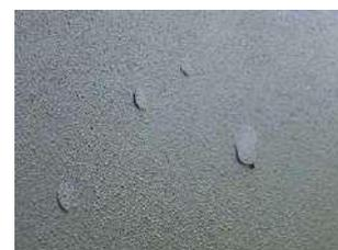
●ポップアウトして仕上材を押し出している例
