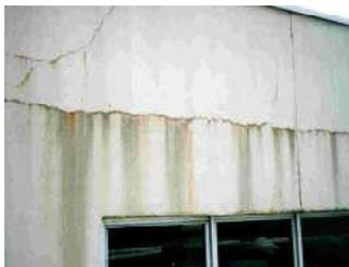
●外壁上部の外周部のひび割れ\*2
