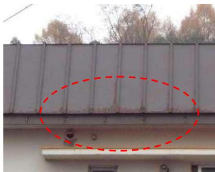
●金属屋根葺き材の腐食（さび）
