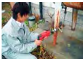
灯油タンクのさび落とし・塗装
