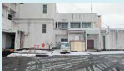
庁舎北側外壁
