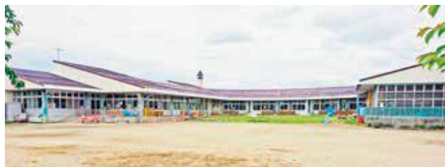
来年度開園に向け改修工事が始まる旧会染保育園
