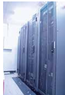
セキュリティ工事が行われる電算室
