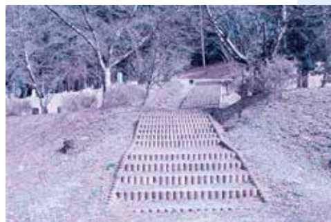
手すりが設置される墓地公園
