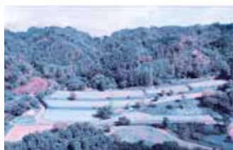
県営中山間総合整備事業の社口原工区
