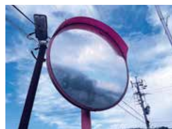
経年劣化により見えにくくなったカーブミラー
