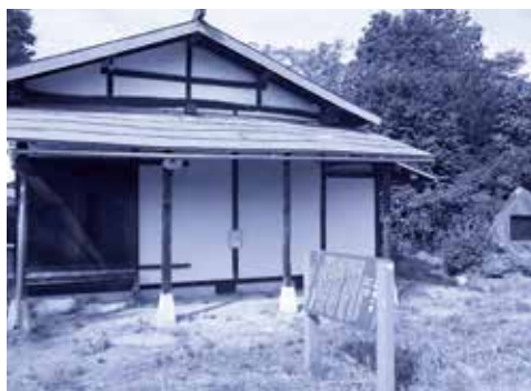
修理が必要な岡麓「終焉の家」(内鎌地籍)
