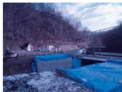
町道八代線落合橋付近
