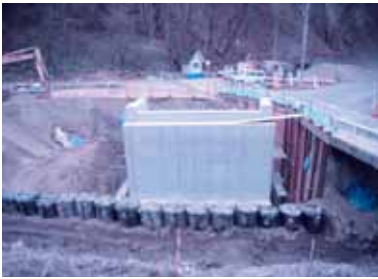
町道八代線落合橋工事(陸郷)
