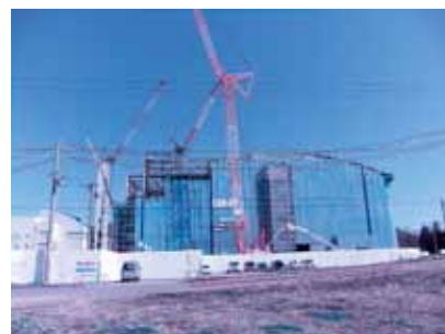
工事中の穂高広域新ごみ処理施設
