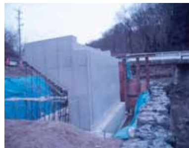
町道八代線落合橋工事
