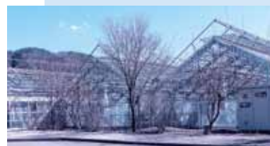
ハーブセンターの温室
