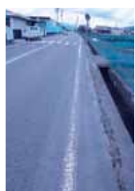
グリーンベルト工事が行われる安曇擁護学校前
