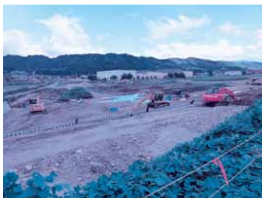
工事が進む会染西部ほ場整備
