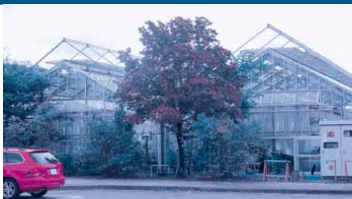
ハーブセンターガラス温室
