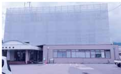
外壁補修工事が進む役場庁舎
