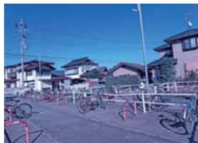
屋根が設置されていない町営駐輪場（松川村）
