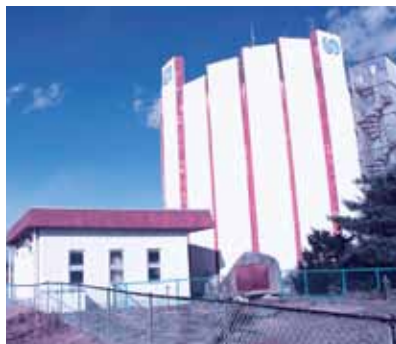
5丁目第5水源施設 (地下44mから揚水)
