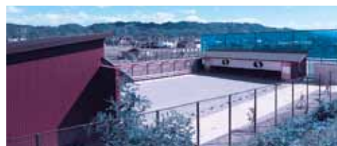
移転新築された弓道場
