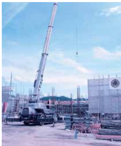
地域交流センター躯体工事
