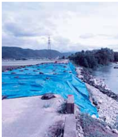
応急工事が完了した 高瀬川中之郷堤防浸食部
