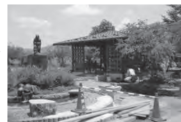
ハープセンターに建設中の足湯
