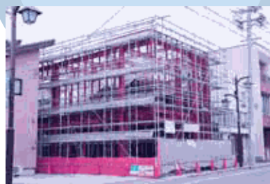
建設中のまちなか賑わい拠点施設
