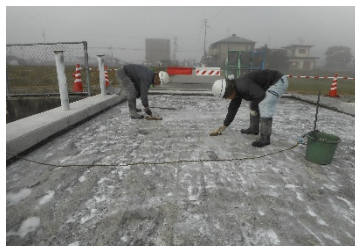
道路橋の修繕
