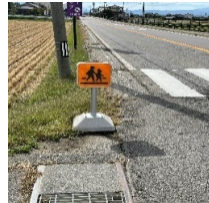
横断歩道反射標識 旗入を設置
