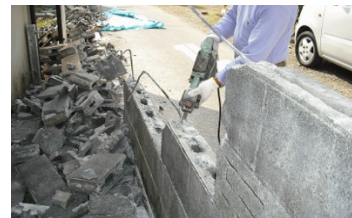
ブロック塀の除却
