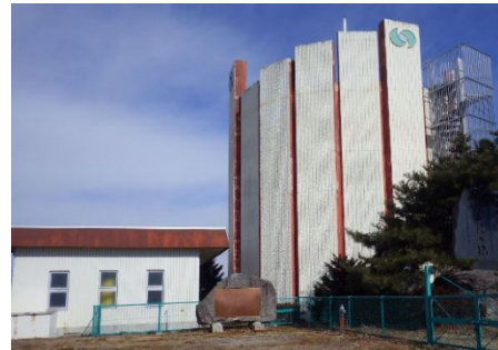
低区配水池（五丁目）
