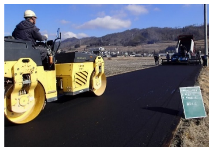
アスファルト舗装
