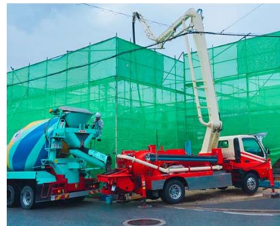
↑ コンクリート打設(イメージ)
