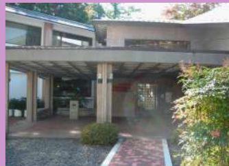
現在の図書館を改修し、文化財管理施設として整備します
