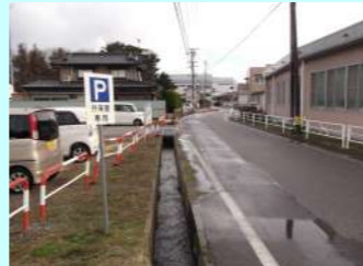
あづみ病院周辺、総合体育館周辺、地域交流センター周辺に道路を新設するとともに狭隘な道路を拡幅します
