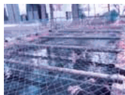
八幡社境内の防火水槽
