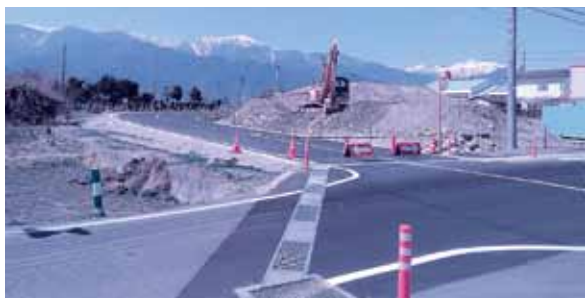
工事が進む新しい町道
