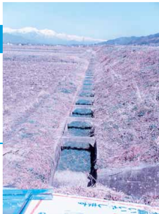
滝沢地区水路
