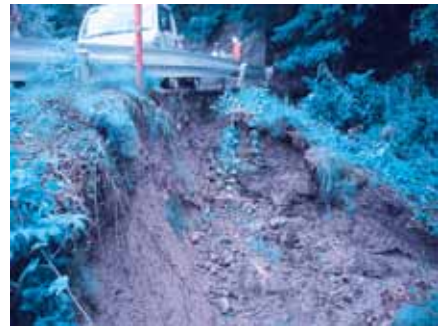
被災した町道登波離橋線(相道寺上)
