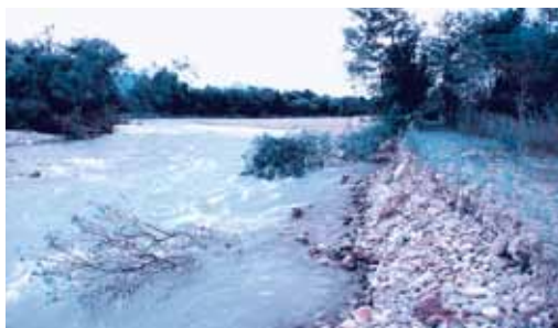
破損した定水位護岸
