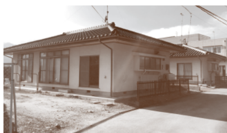
取り壊される教員住宅(あづみ病院南)
