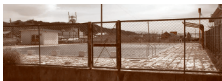
高瀬中プール取り壊し
