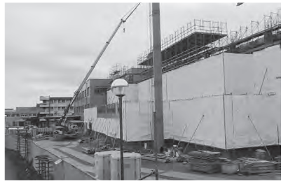
建設中のあづみ病院
