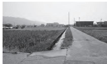
町道238号線工事部(北から南をのぞむ、西町川に蓋をかけ7m幅道路とする)
