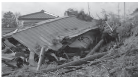
平成16年の台風による町内の被害
