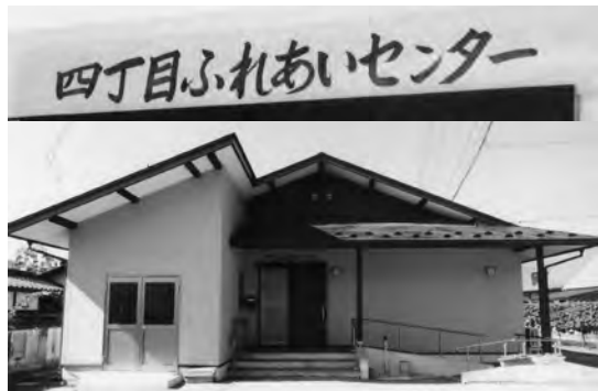
高齢者支えあい拠点施設(4丁目公民館)
