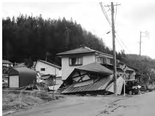
神城断層地震による住宅の倒壊（白馬村）
