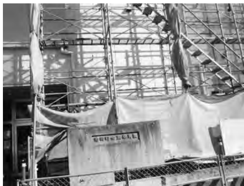
会染保育園の耐震工事
