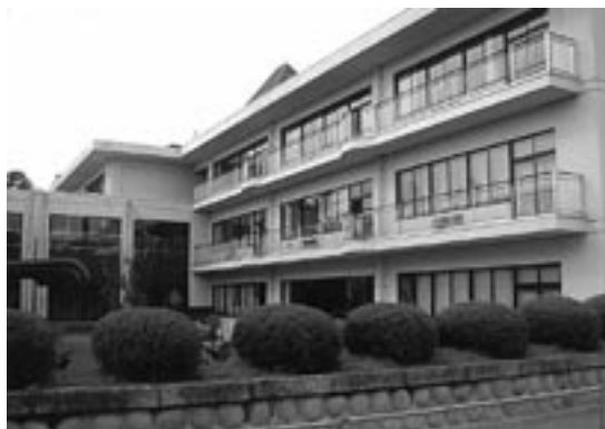
地震対策が必要な校舎の窓ガラス
