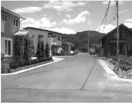
建築が進むあゆみ野団地
