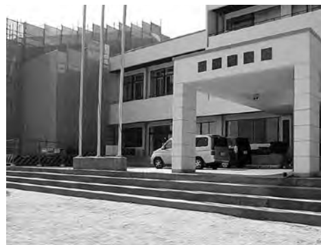
改修工事中の高瀬中学校体育館
