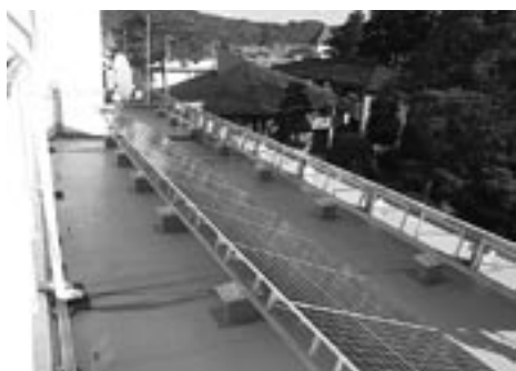
庁舎屋上設置の太陽光パネル
