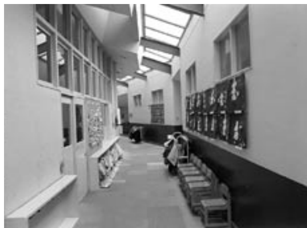
耐震補強が必要な会染保育園
