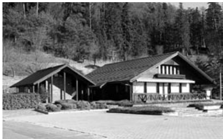
改修されるクラフトパーク休憩施設
