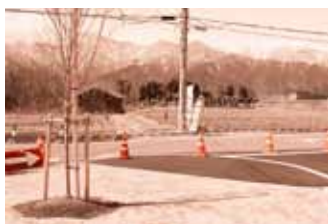
緑地公園が予定されている旧西県道より西の部分
