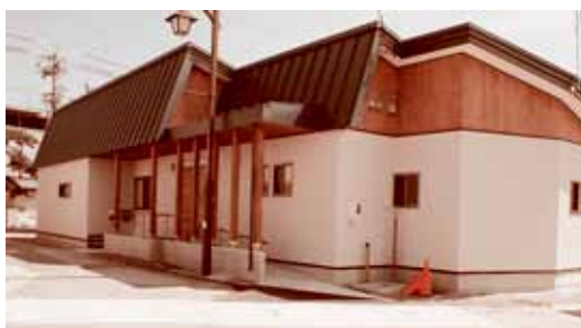
新築された「三丁目高齢者支えあい拠点施設」
