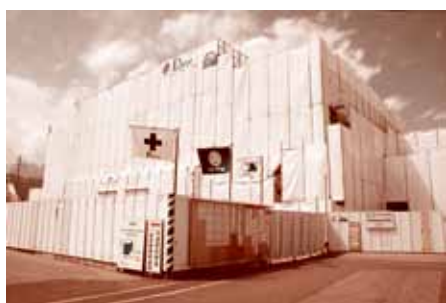
工事中の総合体育館
