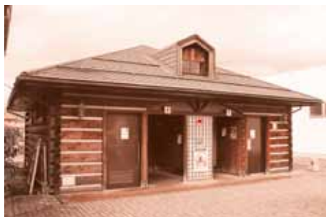
改修されるハーブセンターのトイレ
